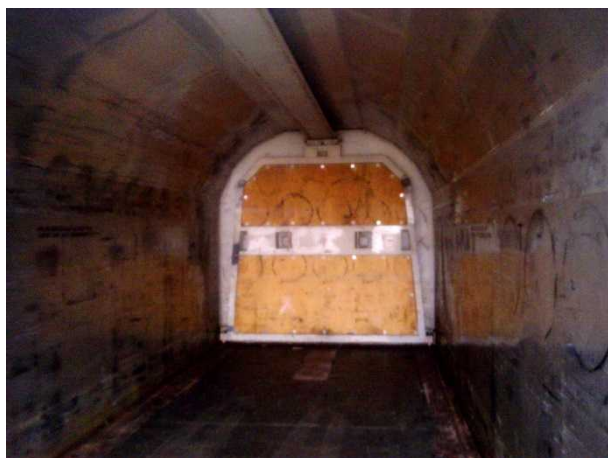
Рис. 2. Загальний вигляд рухомої внутрішньої перегородки, яка травмувала прикордонника
